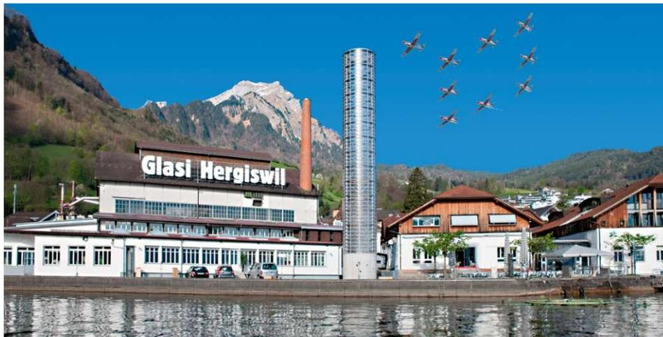
Der 20 Meter hohe Glas-Turm wurde zum 200-jährigen Bestehen der Glasi Hergiswil im Jahr 2017 erbaut. Er besteht aus 24 Tonnen Stahl und 672 handgegossenen Glasplatten (7 Tonnen) aus der Glasi.
